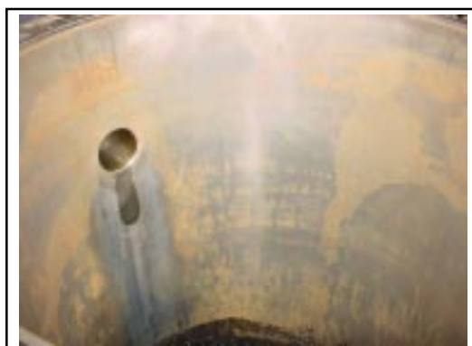
PAREDE INTERNA DE UM TANQUE DE ÁGUA PURIFICADA APRESENTANDO ROUGE
