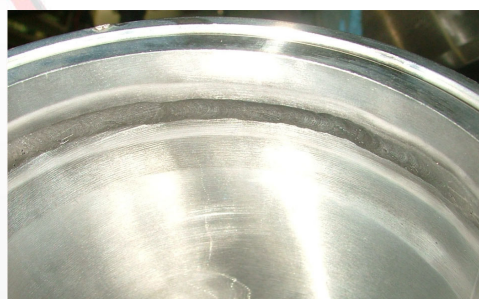
Emenda de solda após a limpeza
