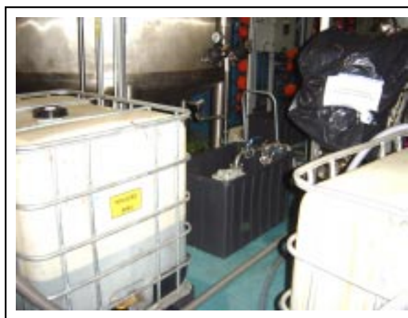
TRABALHO OPERACIONAL DE PASSIVAÇÃO
