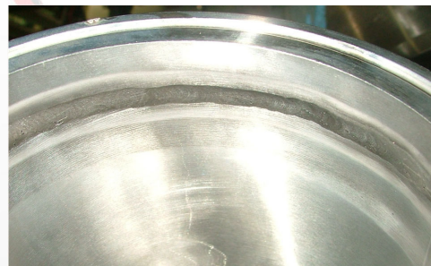
Emenda de solda após a limpeza
